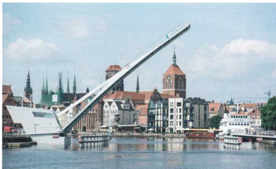
Kładka zwodzona na Wyspę Ołowiankę
