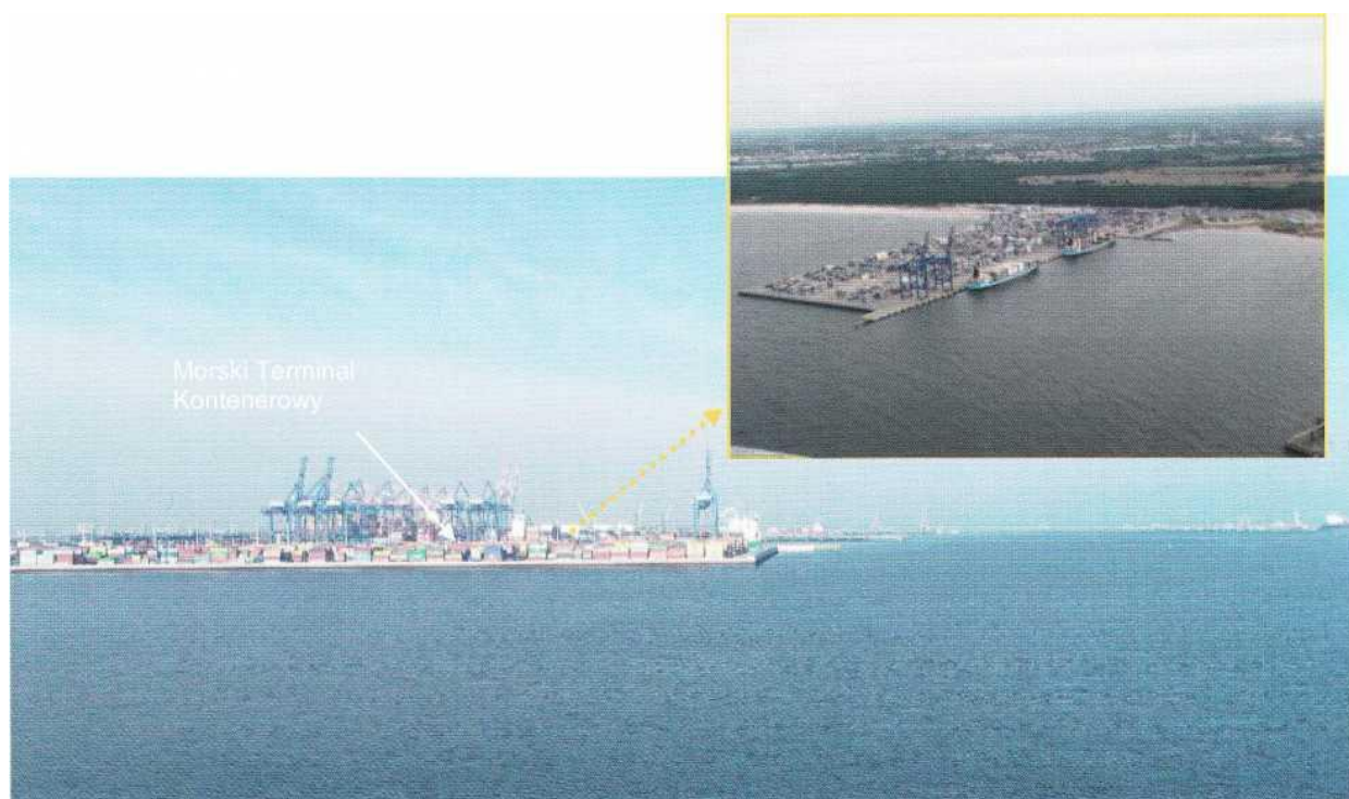
Port Północny – na wschód od wejścia głównego
