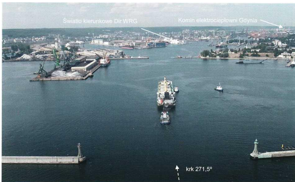
Gdynia – wejście główne
