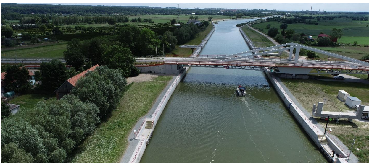
Podejście do Elbląga – Nowakowo. Most Obrotowy
