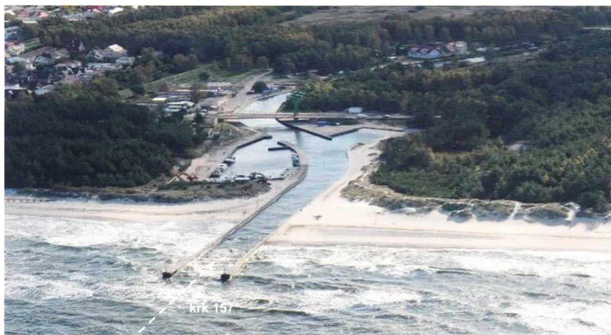
Dźwirzyno – wejście do portu
